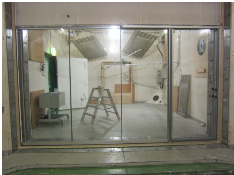
Kuva 2, seinä asennettuna kaiuntahuoneiden väliseen asennusaukkoon
