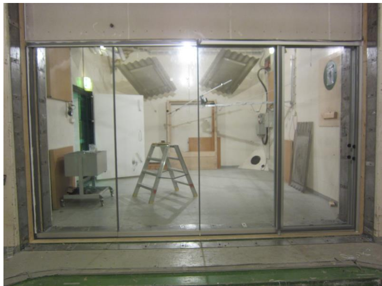
Kuva 2, seinä asennettuna kaiuntahuoneiden väliseen asennusaukkoon
